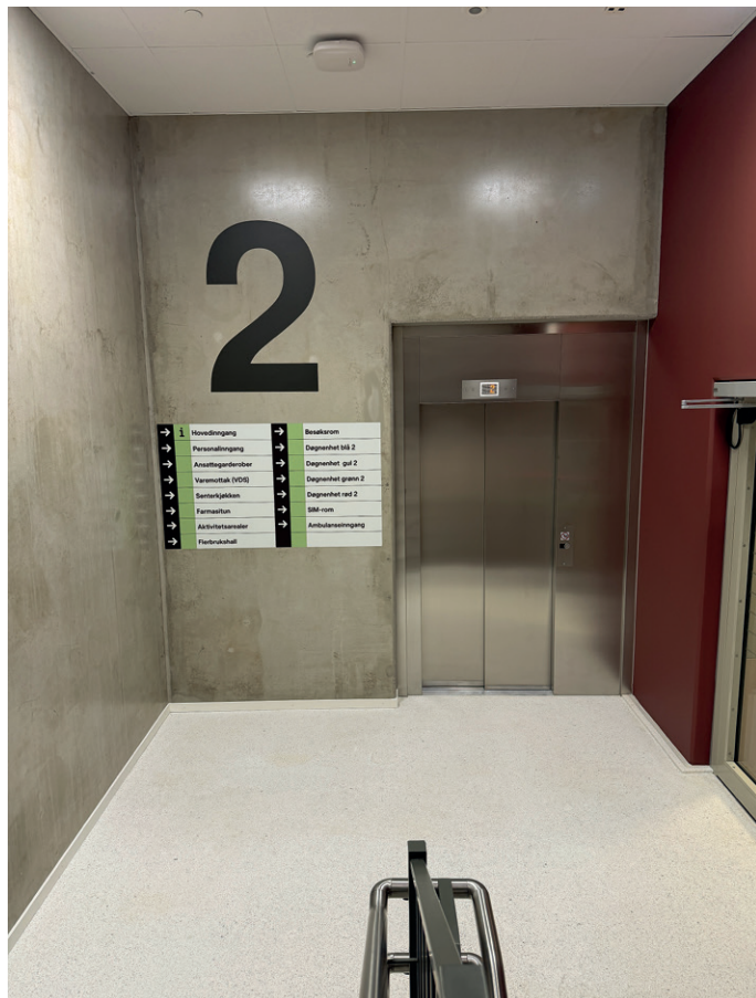
Ekspontert betong med fin finish kan sees i trappeoppgangene.
