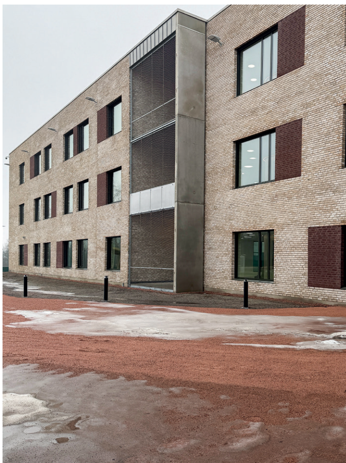
Byggene har teglforblending som myker opp inntrykket.
